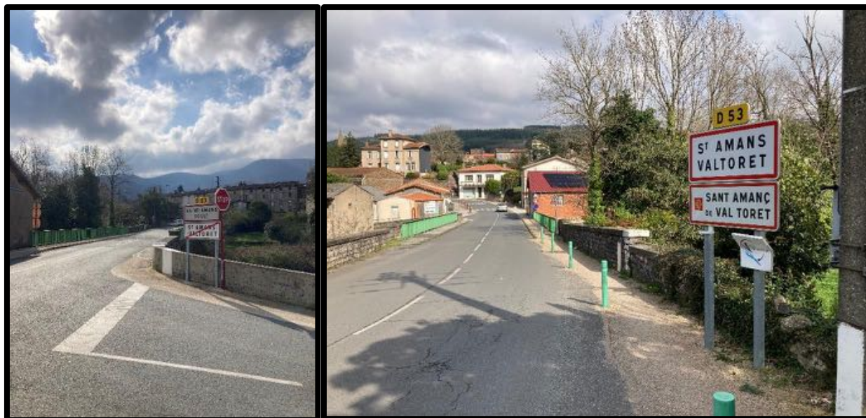
Photo n°1 et 2 : Pont séparant les communes de Saint-Amans-Soult et Saint-Amans-Valtoret. © Anthony RILCY 15
